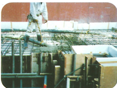
5. コンクリート打設
