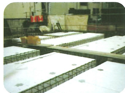
3. コープランKM設置完了
